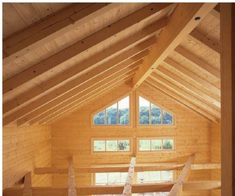
Konstrukcję z drewna warto zabezpieczyć impregnatem
