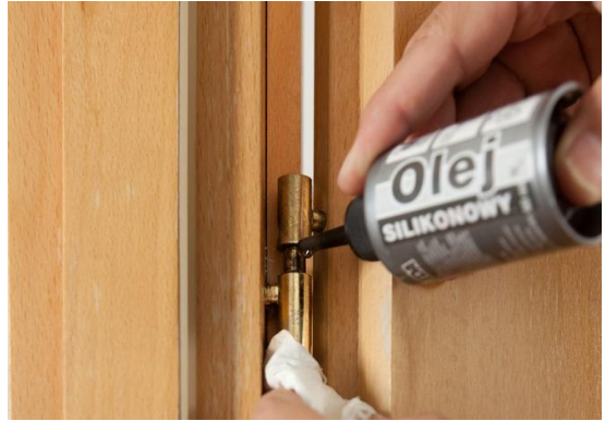
Oliwienie metalowych zawiasów
